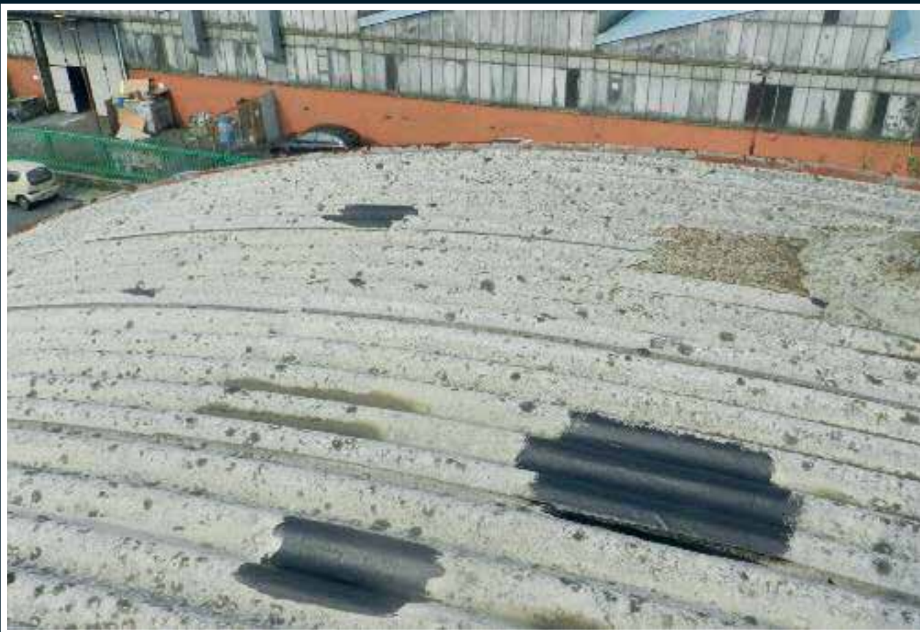
Evidente risultato della rottura della copertura in fibro-cemento per effetto delle grandine
